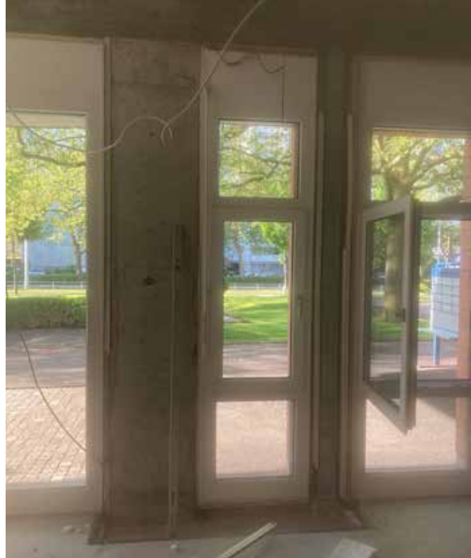
Noch steht die schmale Fensterfront, bevor diese herausgerissen und die Betonwand gegossen wurde
